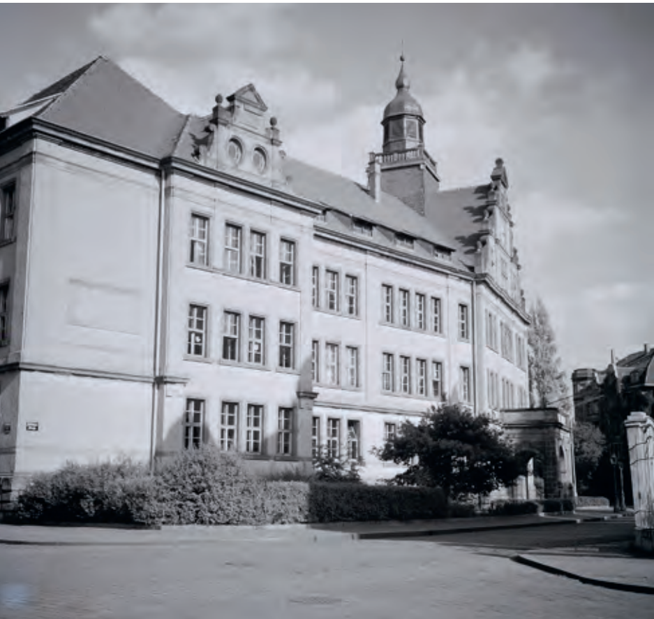
Abb. 3 Gaudig-Schule vor 1945, Döllnitzer Straße 2 (heute Lumumbastraße 2).
